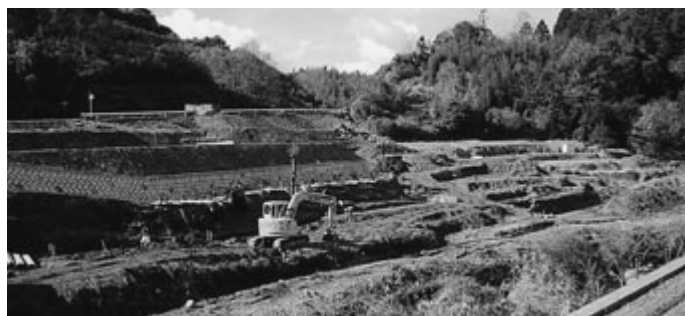
水分地区のほ場整備
