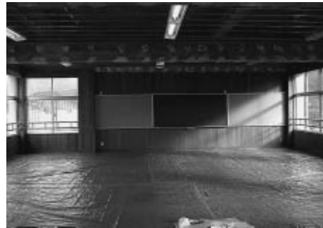
工事中の小吹台小音楽教室
