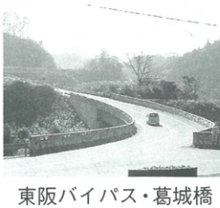
東阪バイパス・葛城橋
