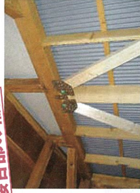
接合部の補強
