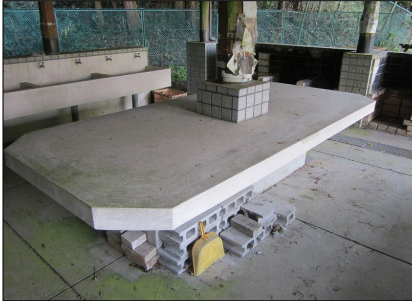
位置: 炊事棟(調理台、窯) 撮影日: 令和4年12月2日
