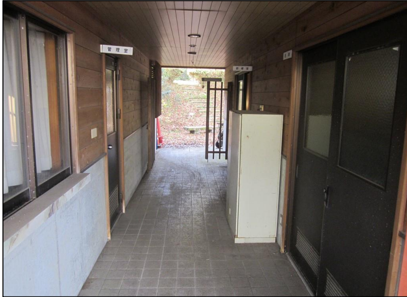
位置: 管理棟内部 通路 撮影日: 令和4年12月2日
