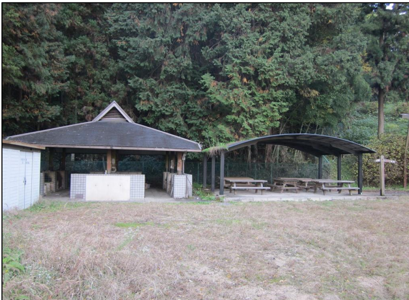
位置: 炊事棟、屋根付きテーブルベンチ 撮影日: 令和4年12月2日
