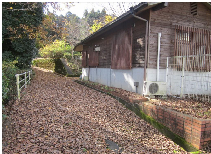
位置: 管理棟横 車進入路 撮影日: 令和4年12月2日
